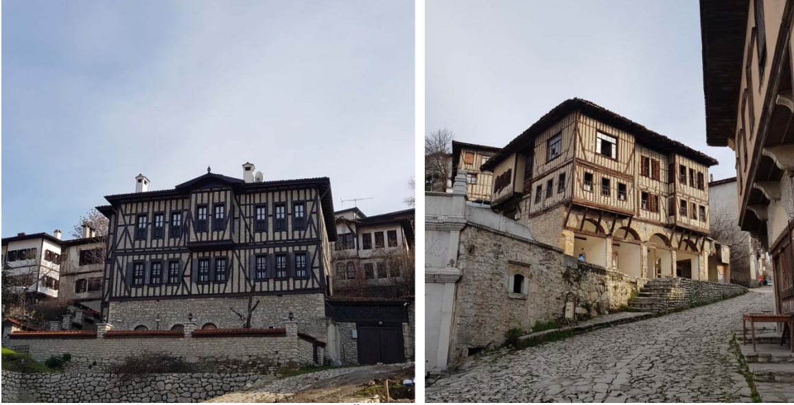
Şekil 5. Safranbolu evleri, ahşap çatki sistemi (Öztürk, 2019).
