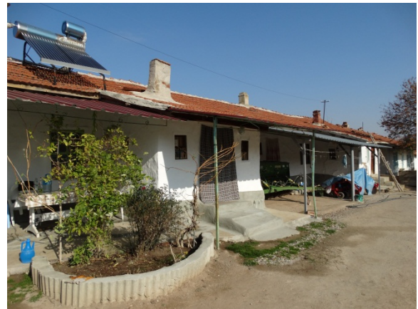
Şekil 7: 134 Ada, 19-20 Parseldeki konutun ön cephesi (2018).
