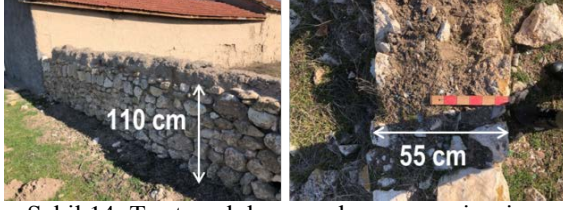
Şekil 14: Taş temel duvarı subasman seviyesi ve duvar genişliği (2019).
