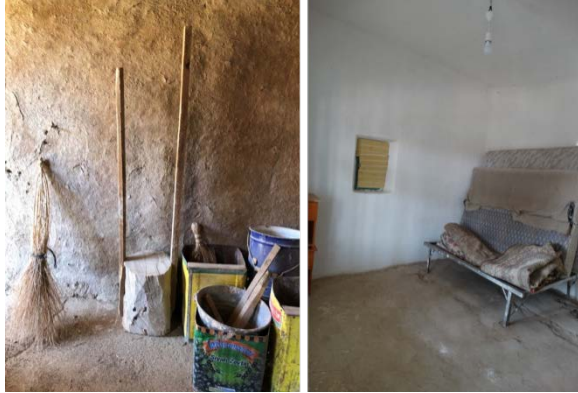
Şekil 16: Zemin sıkıştırma için kullanılan ahşap tokmak ve toprak zemin (2019).
