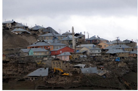
Şekil 5: Doğa kaynaklı nedenlerle tahliye edilen kırsal yerleşimlere bir örnek: Elazığ-Kovancılar, Okçular Köyü. 5
