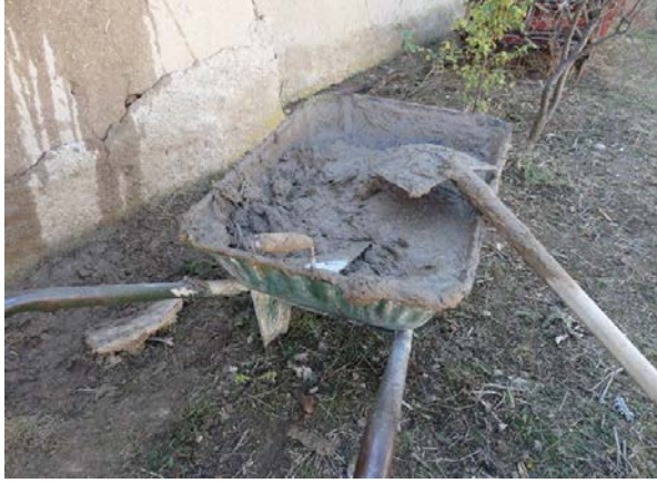
Şekil 15: 'Çorak toprak', ince saman ve su karışımından oluşan çamur harç (2018).
