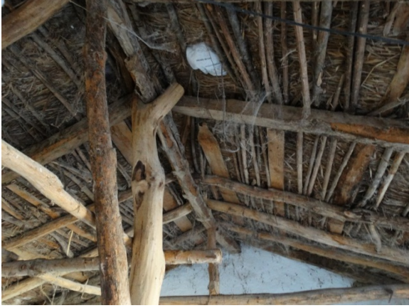
Şekil 18: Ambarda ahşap çatıklı, bitkisel malzeme örtülü geleneksel çatı sistemi. (2018).
